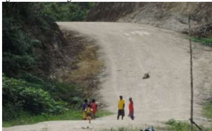
Gambar 3. Ruas Jalan Kampung Suwiam
