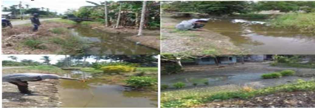
Gambar 5. Kondisi Eksisting saluran drainase Kelurahan Koya Timur
