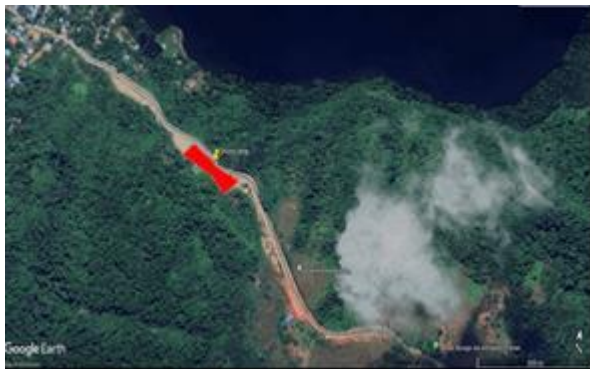
Gambar 3. Lokasi Pekerjaan Shortcrete Sumber: Google Earth, 2023
