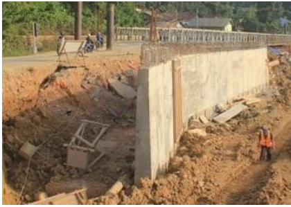
Gambar 13. Pengamanan Oprit Jembatan Dengan Dinding Kantilever Dari Beton Bertulang
