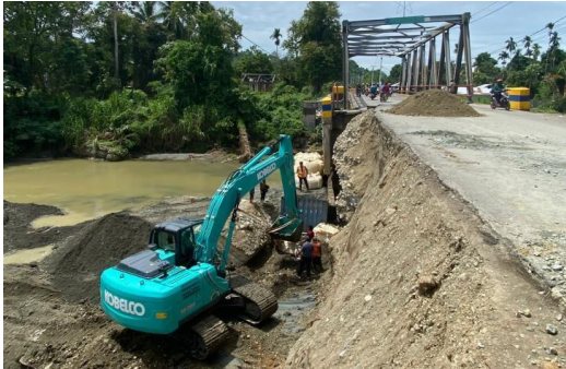
Gambar 9. Penggalian Dasar Penahan Sumber: Dokumentasi Lapangan, 2023
