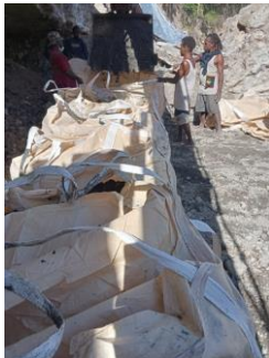
Gambar 10. Pengisian Karung Dengan Material Sirtu Sumber: Dokumentasi Lapangan, 2023
