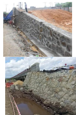
Gambar 12. Pengamanan Oprit Jembatan Dengan Pasangan Batu
