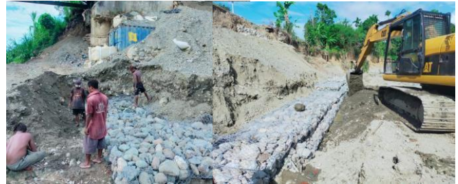
Gambar 11. Proses Pengerjaan Bronjong Sumber: Dokumentasi Lapangan, 2023
