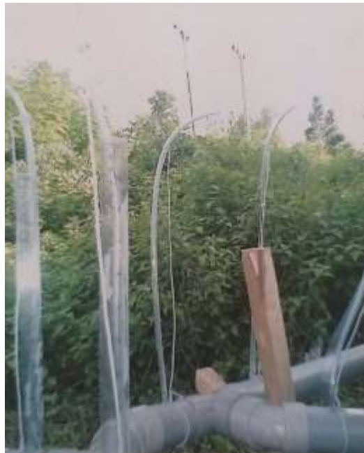
Gambar 7. Pipa kapiler yang dipasang pada sistem untuk mengukur tekanan statis
