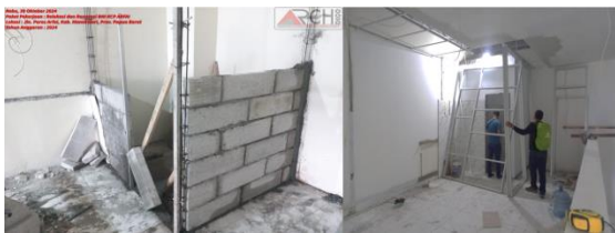
Gambar 3. Pekerjaan Pemasangan Dinding Batu Hebel pada KM/WC Lantai 1
