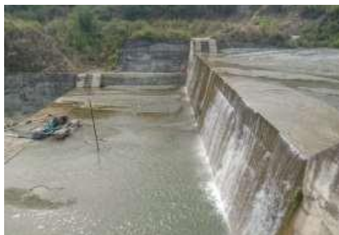
Gambar 4. Bangunan Pengendali Banjir (Sabo Dam) di Kawasan Sentani
