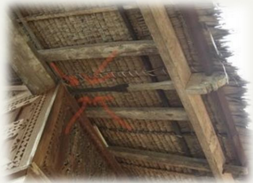
Gambar. 11 Cara mentimpul tali pada struktur atap
