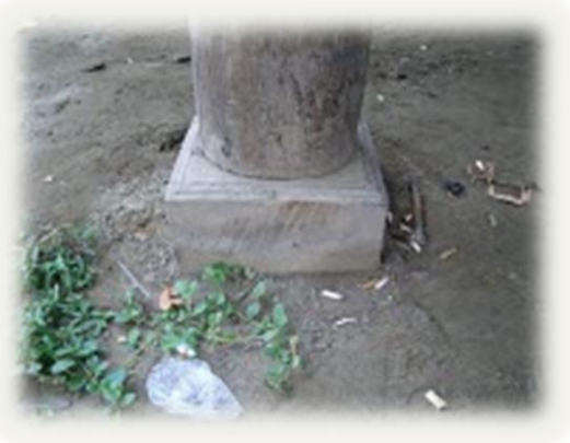
Gambar. 13. Tiang Pondasi pada Rumoh Aceh
