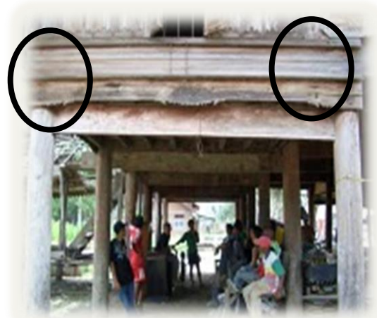
Gambar. 12 balok kayu yang menghubungkan antar tiang-tiang
