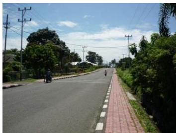
Gambar 1. Kondisi Jalan di Kabupaten Nabire
