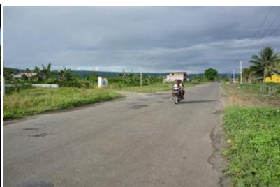
Gambar 2. Kondisi Jalan Luar Kota Di Kabupaten Nabire
