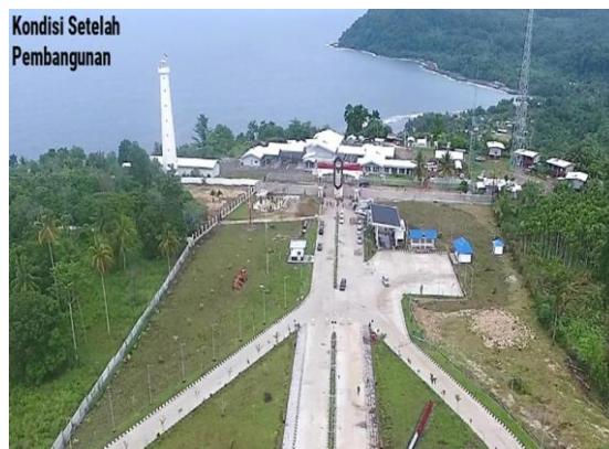
Gambar 3. Kondisi setelah pembangunan Pos Lintas Batas Wilayah RI-PNG
