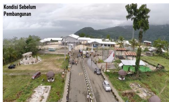
Gambar 2. Kondisi sebelum pembangunan Pos Lintas Batas Wilayah RI-PNG
