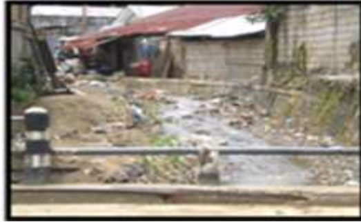
Gambar 3. Pendangkalan Saluran Pada DAS Sian Nan (Entrop I)
