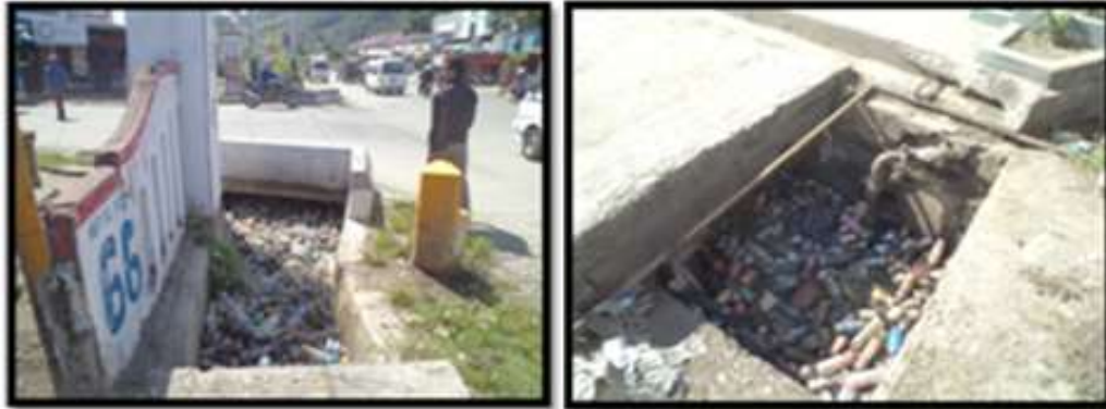
Gambar 4. Penyumbatan Saluran Drainase Oleh Sampah
