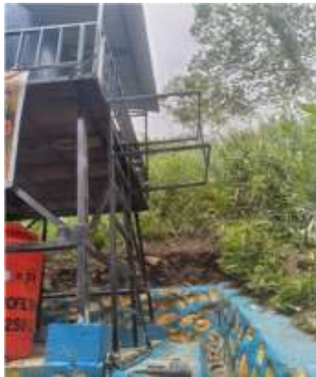
Gambar 3 (a) Pembuatan Tangga samping pada menara air
