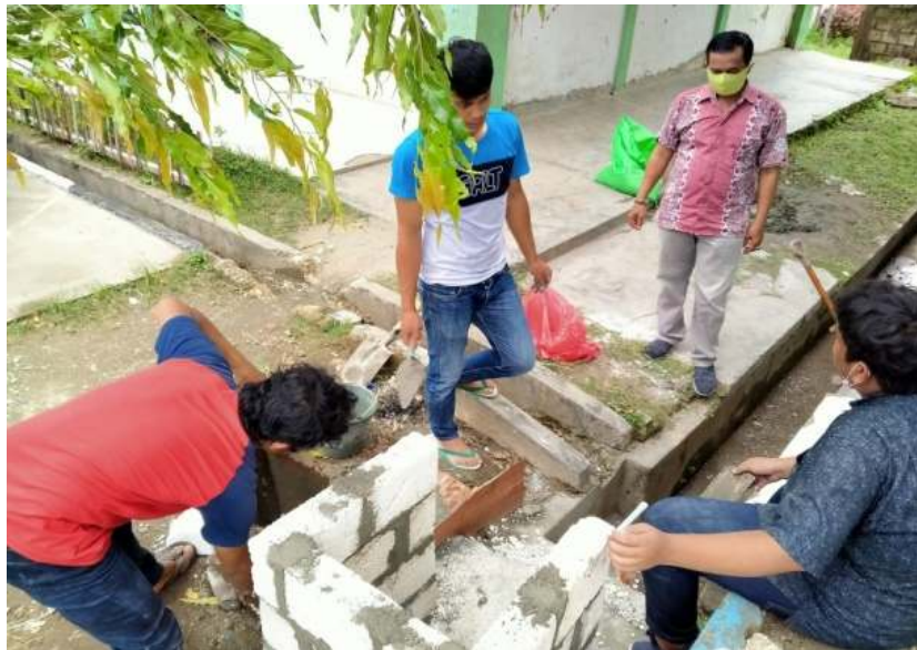
Gambar 2. Tahap Pembangunan Wastafel
