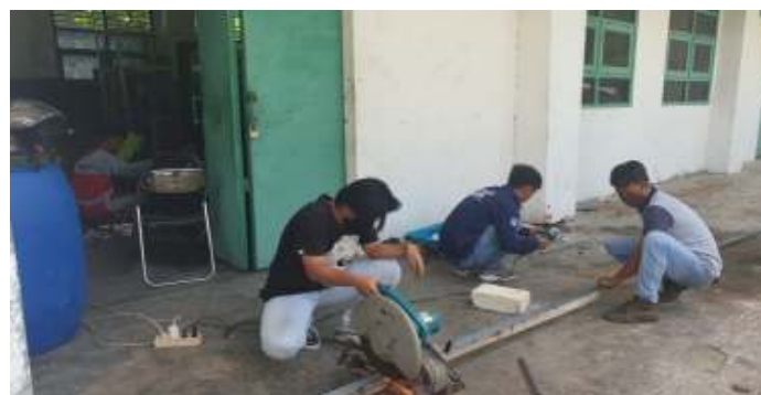
Gambar 4. Mengerjakan Wastafel Pencuci Tangan Mechanical
