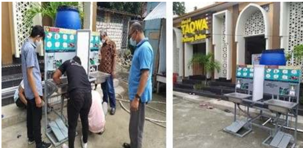
Gambar 4. Instalasi dan Pemasangan Alat Cuci Tangan di Masjid
