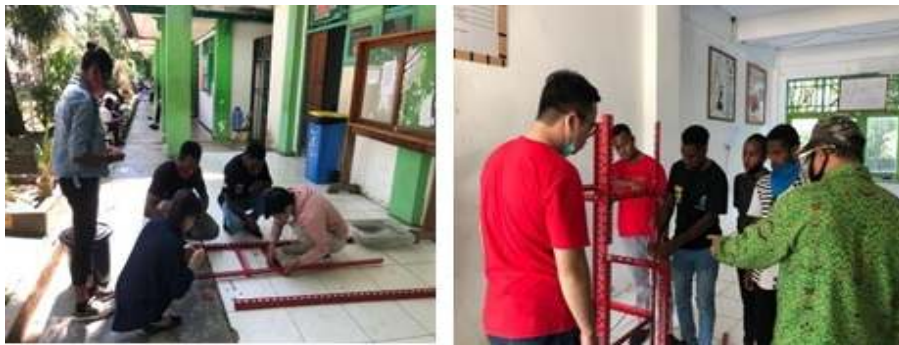
Gambar 5. Pembuatan rangka wastafel
