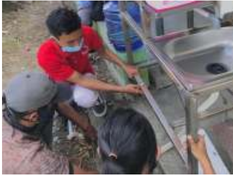
Gambar 4. Pemasangan wastafel sesuai lokasi yang telah ditetapkan
