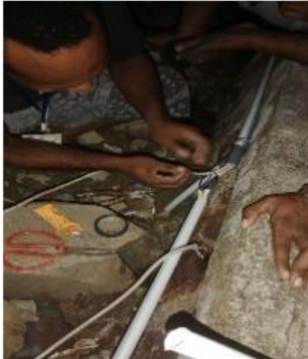
Gambar 6. Proses pemasangan kabel dalam pipa
