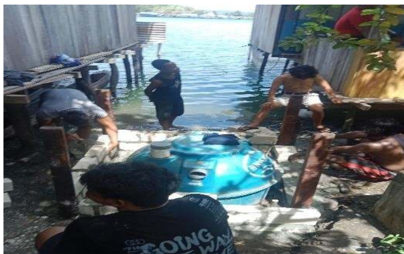
Gambar 7. Pengerjaan Pengolahan Tinja Menggunakan Bahan Pengurai Untuk Septictank
