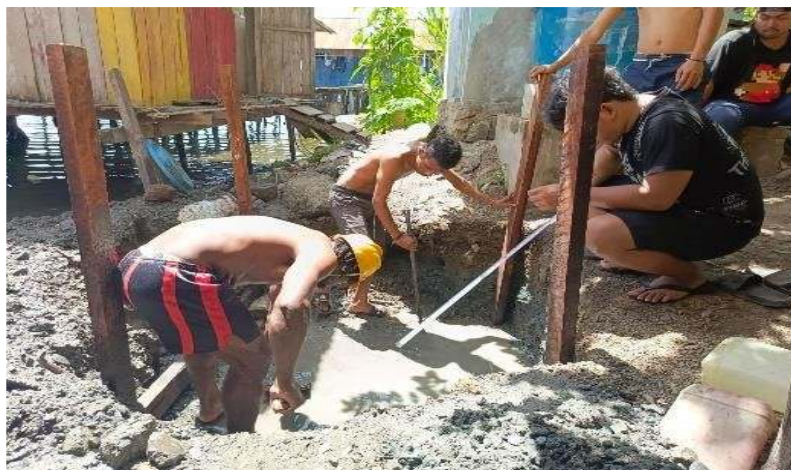
Gambar 6. Pengerjaan Pemasangan Septictank Biorich
