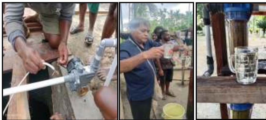
Gambar 5 : Pemasangan Pompa Listrik dan Kondisi Air Sebelum dan Sesudah Filtrasi
