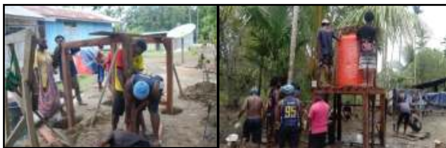
Gambar 4 : Pembangunann Menara Tandon
