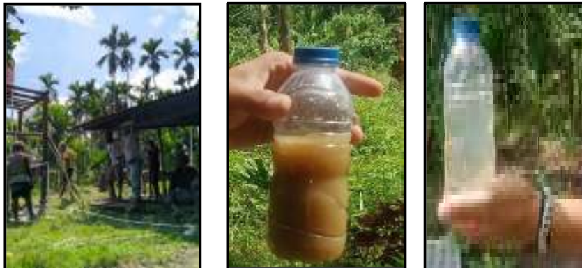
Gambar 5 : Pemasangan Pompa Listrik dan Kondisi Air Sebelum dan Sesudah Filtrasi
