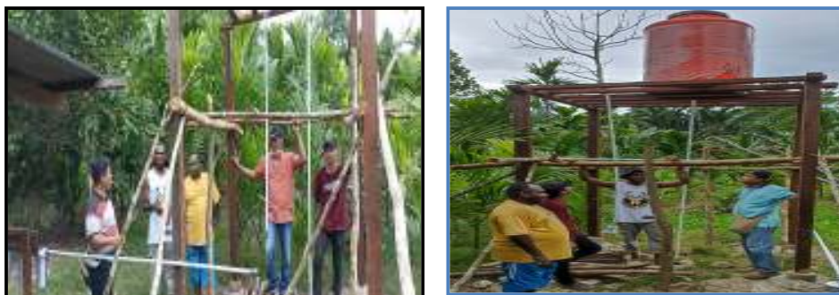
Gambar 4 : Pembangunan Menara Tandon
