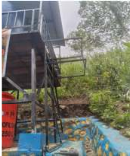
Gambar 3 (a) Pembuatan Tangga samping pada menara air
