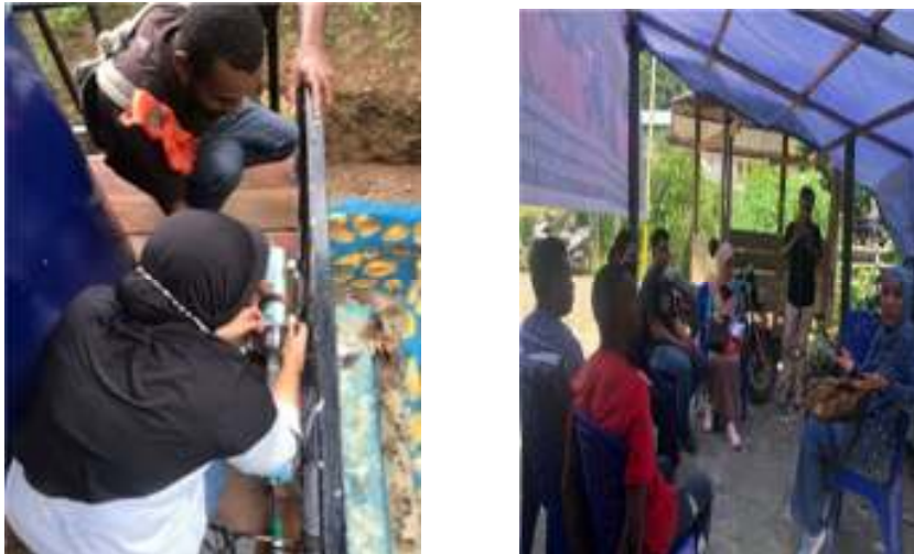
Gambar 4 (a) Bimbingan teknis pemasangan instalasi air bersih kepada masyarakat mitra
